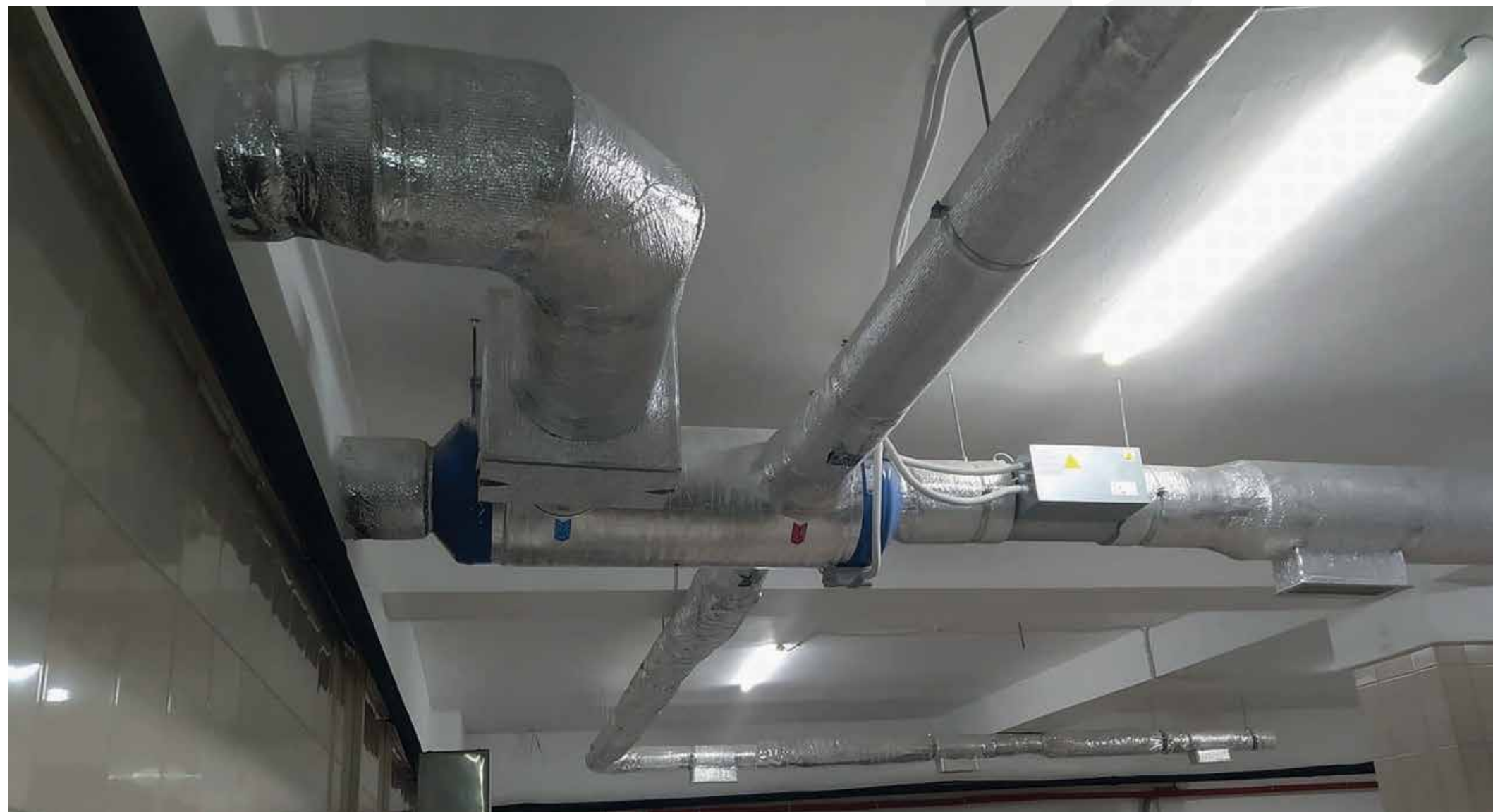
Centralizovana ventilacija proizvodnje sira u fabrici (Ukrajina, Lvov) (rekuperator PRANA-340S)
