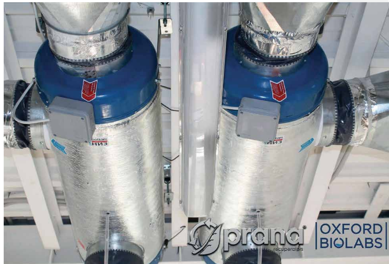
Rekuperator PRANA-340S, unutrašnja montaža
