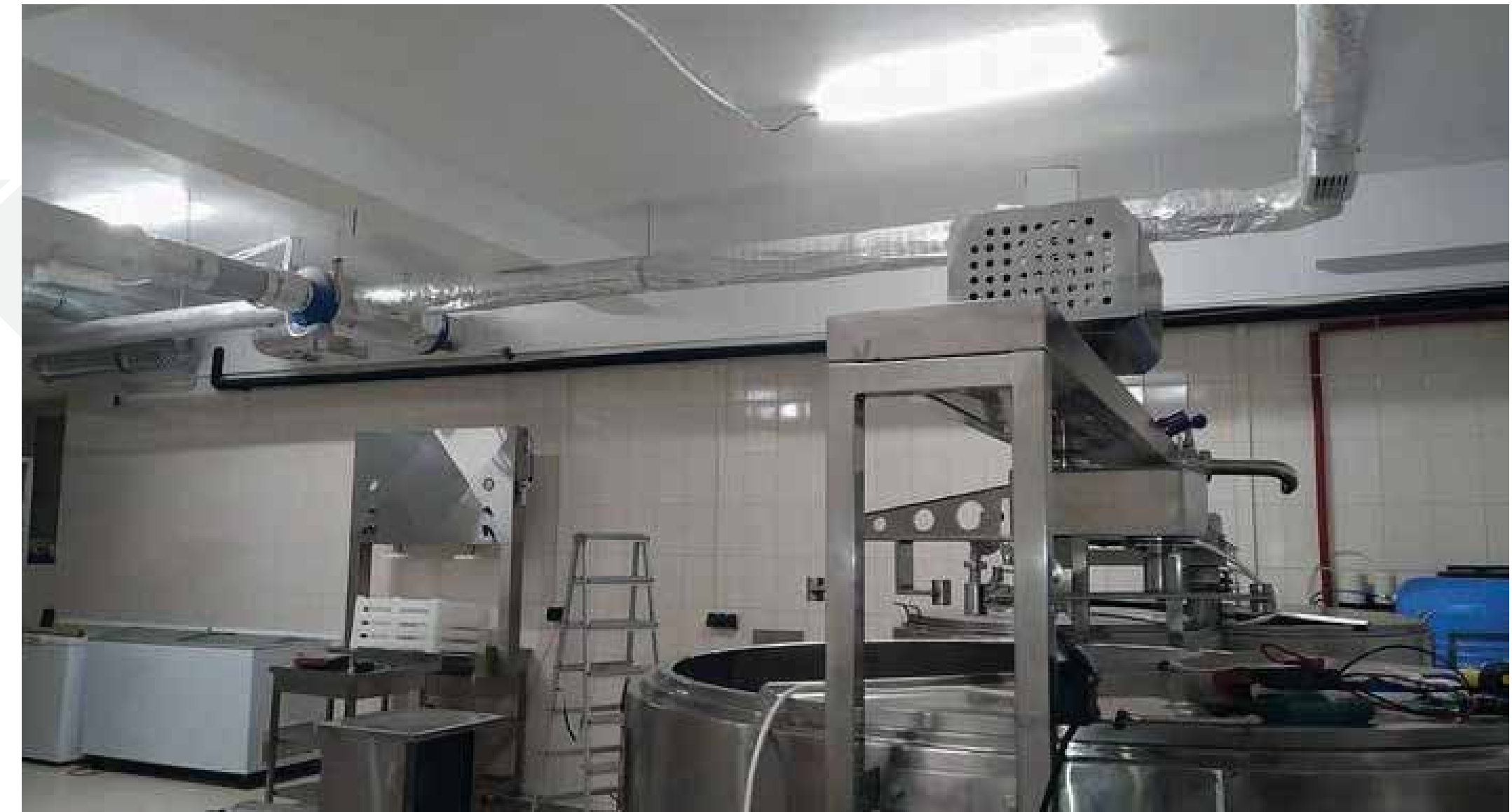
Centralizovana ventilacija proizvodnje sira u fabrici (Ukrajina, Lvov) (rekuperator PRANA-340S)
