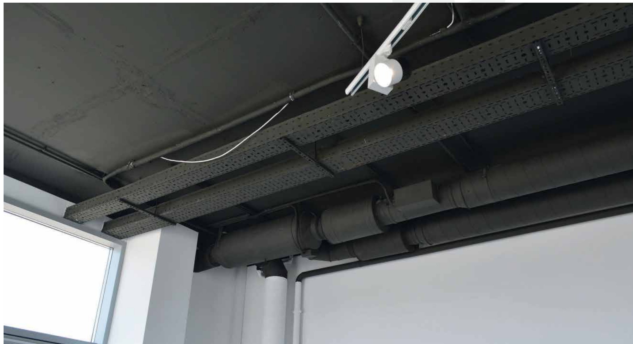
Централизованная вентиляция салона дверей и пола (Украина, Львов) (рекуператор PRANA-340S)
