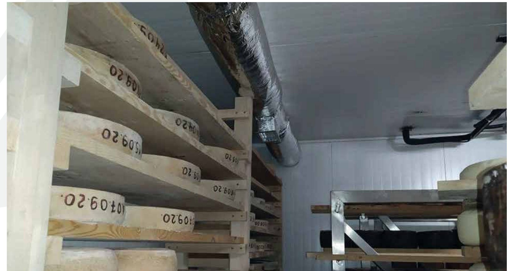
Centralizovana ventilacija proizvodnje sira u fabrici (Ukrajina, Lvov) (rekuperator PRANA-340S)
