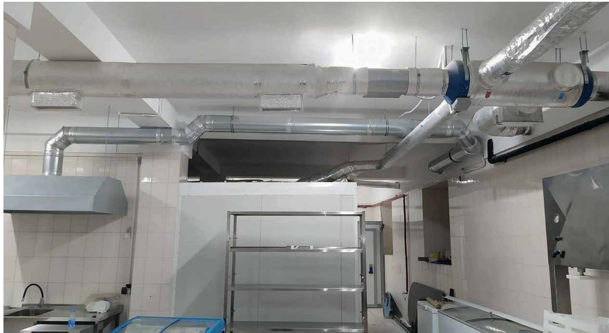
Centralizovana ventilacija proizvodnje sira u fabrici (Ukrajina, Lvov) (rekuperator PRANA-340S)
