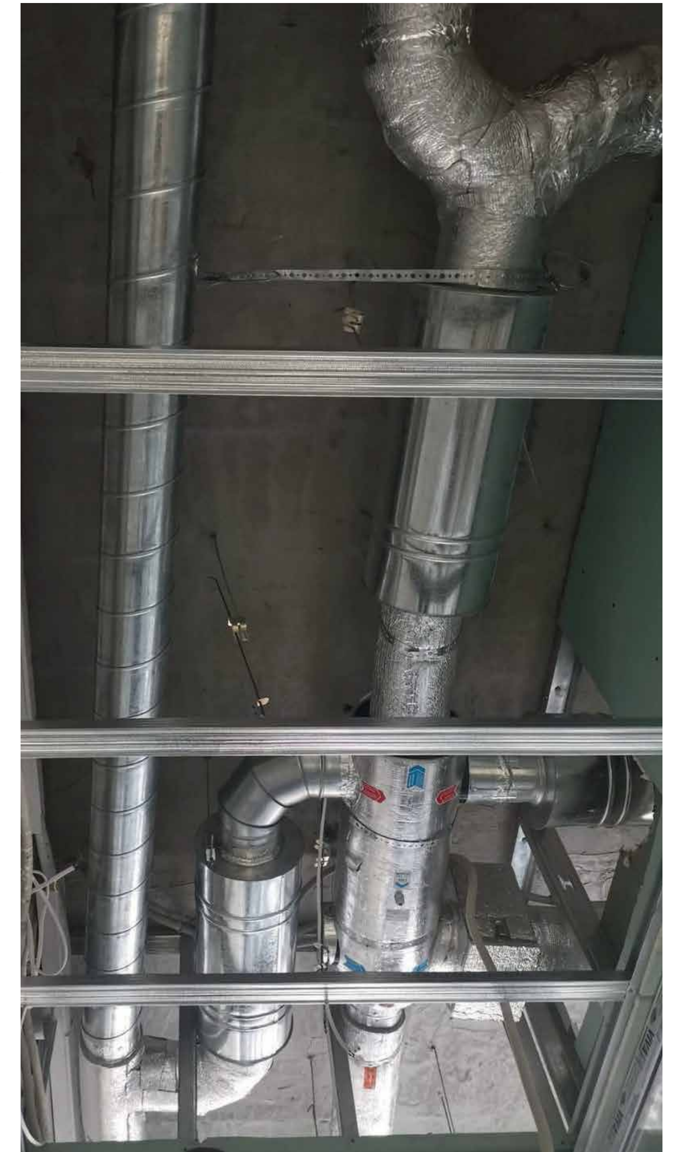
Rekuperator PRANA-340S, unutrašnja montaža
