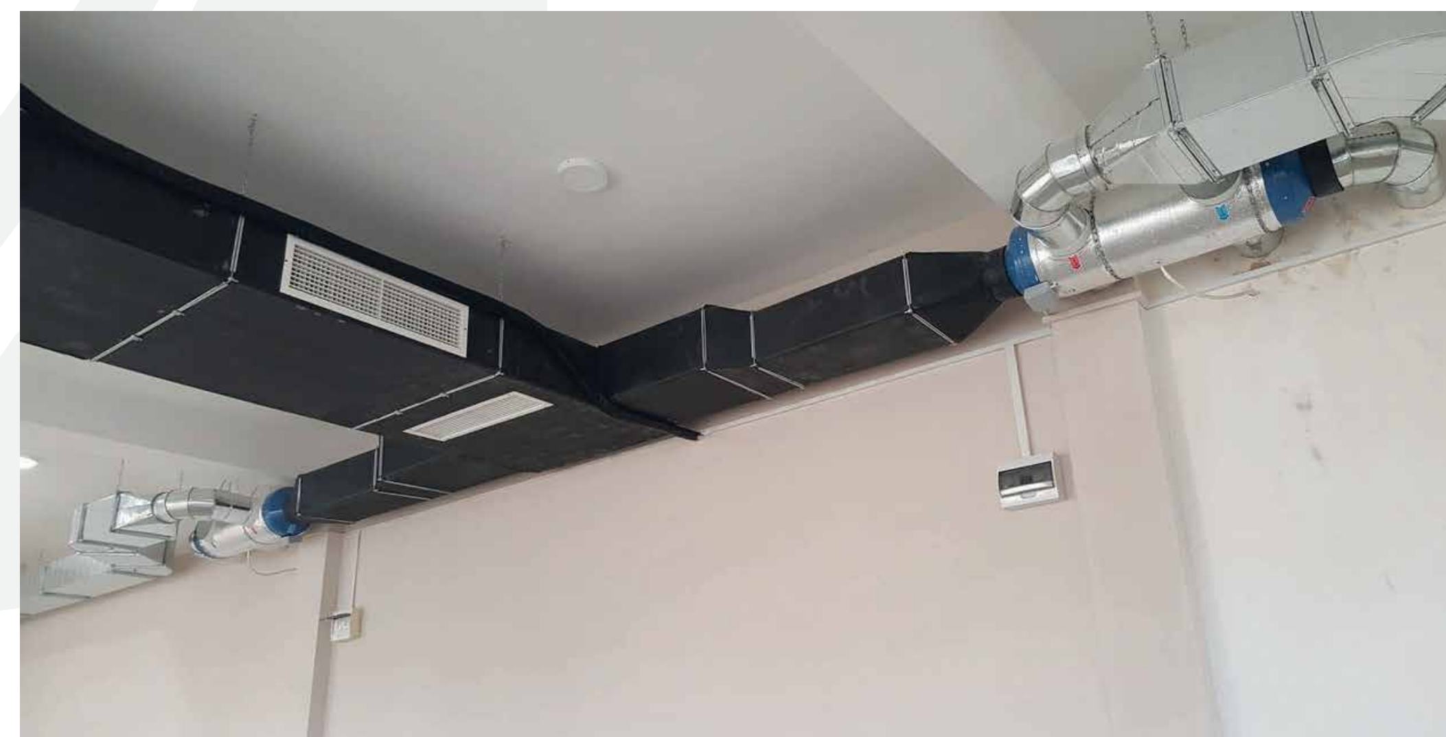
Rekuperator PRANA-340S, unutrašnja montaža, sa dva REKUPERATORA na zajedničkom dovodnom vazдушnom kanalu.
