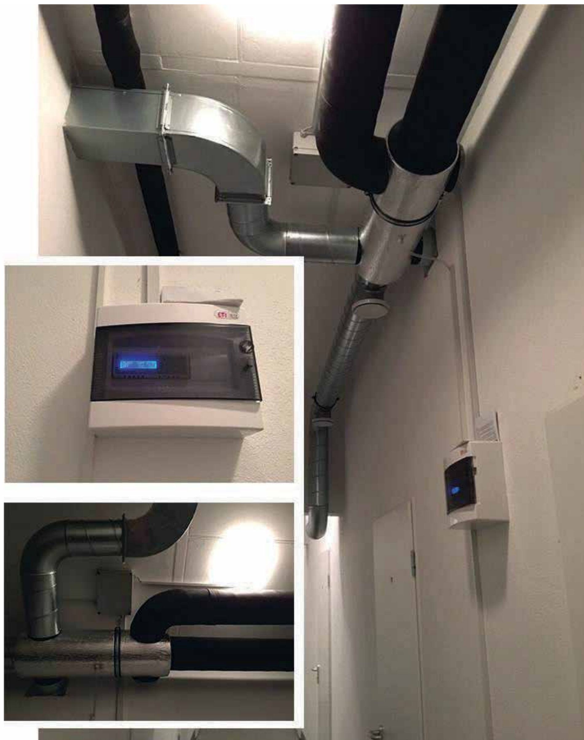
Rekuperator PRANA-250, unutrašnja montaža
