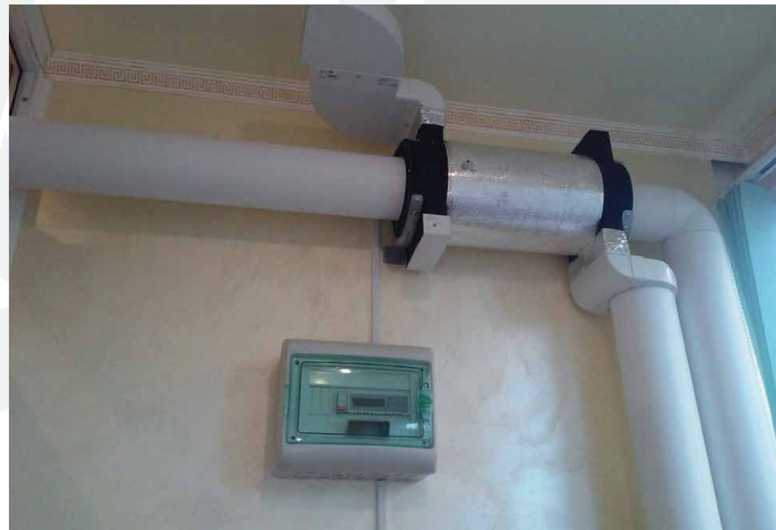
Rekuperator PRANA-250, unutrašnja montaža
